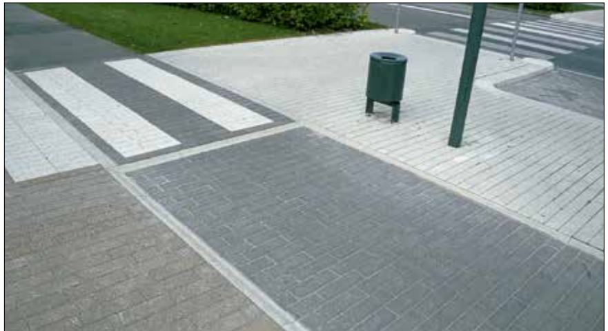
Figur 2.2. Adskillelse af biler, cyklister og gående kan ske smukt og effektivt med betonsten i forskellige farver og varierende overflader. (Allerød).
