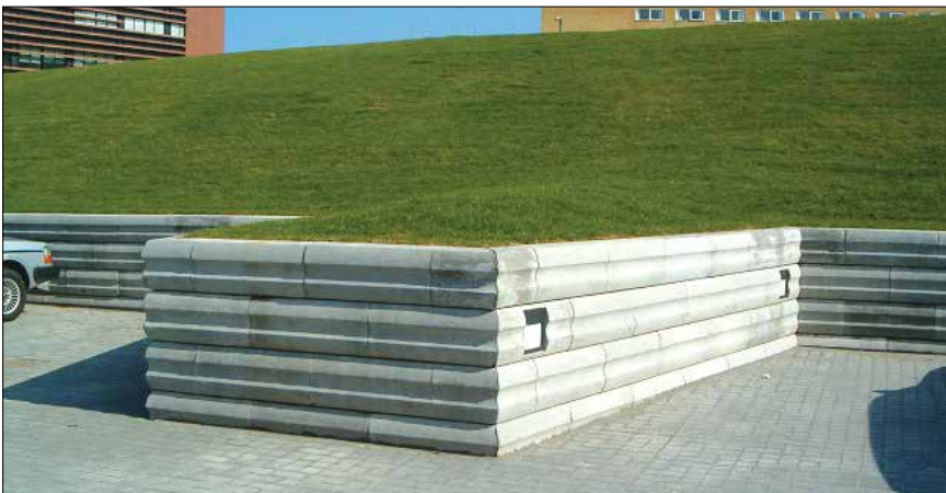
Figur 3.58. Støttemur. Det er vigtigt ved dimensioneringen at tage højde for belastningen oven for muren, f.eks. som her jordvolden.
