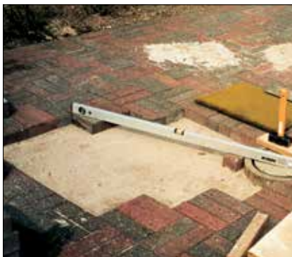
Figur 4.18. Ved brønddæksler og lignende opstår der ofte lunker på grund af for dårlig komprimering, eller manglende overhøjde ved lægningen. Oprettningen udføres dog let.
