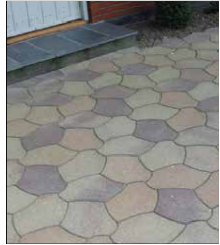
Figur 4.8. Til venstre ses almindelige kalkudfældninger på farvede sten. Billedet til højre viser samme belægning 2 år senere. Det ses, at kalkudfældningerne er væk, hvilket skyldes almindeligt slid samt vind og vejr generelt.
