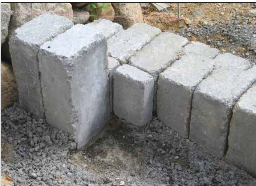
Figur 3.51. Sætning af trappe i jordfugtig beton.
