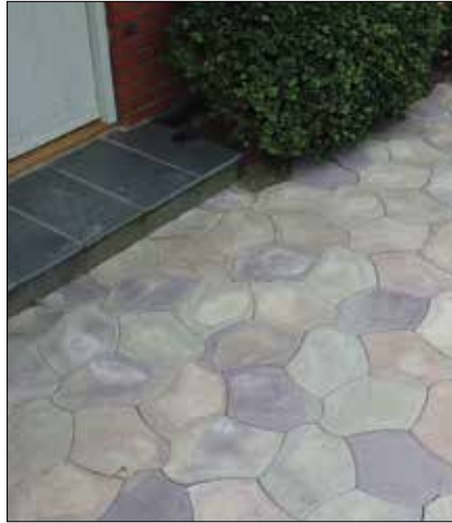
Figur 4.8. Til venstre ses almindelige kalkudfældninger på farvede sten. Billedet til højre viser samme belægning 2 år senere. Det ses, at kalkudfældningerne er væk, hvilket skyldes almindeligt slid samt vind og vejr generelt.
