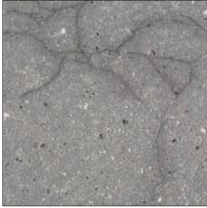
Figur 2.51. Eksempel på alkaliselreaktioner, også kaldet "spindelvæv".
