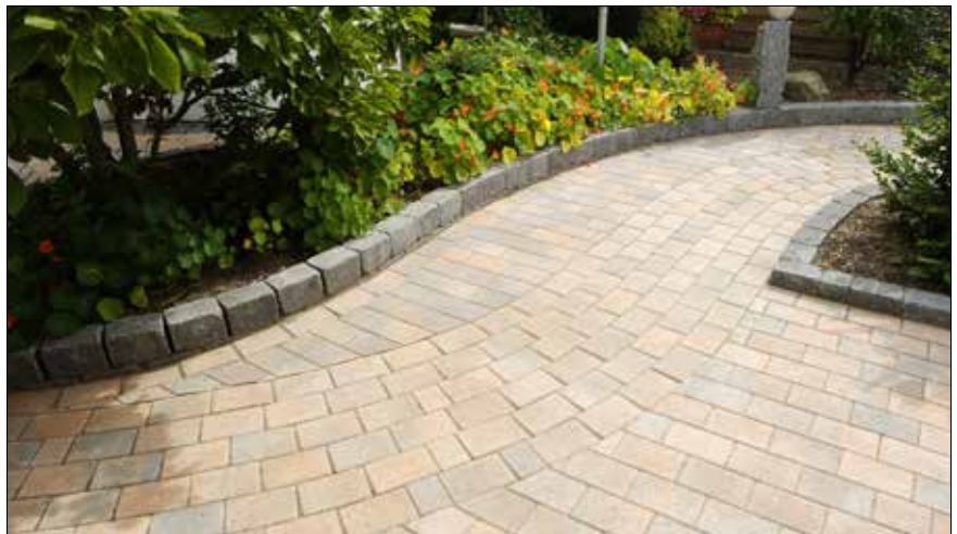
Figur 2.12. Betonsten og -fliser leveres i mange forskellige farver og nuancer, og med forskellige former efterbehandling.
