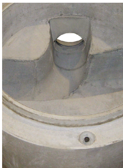
Rørmaterialets overflade har betydning for vandføringsevnen
