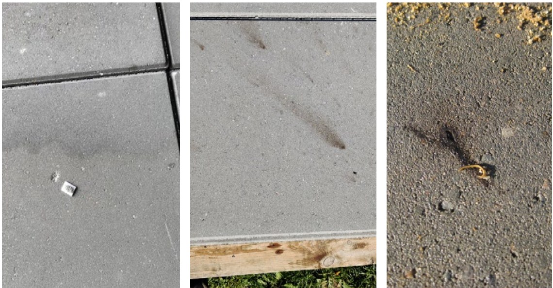
Figur 99 – Andre typer af fremmedlegemer i betonoverflader, såsom plastik (tv.), kul (mf.) og træfibre (th.).
