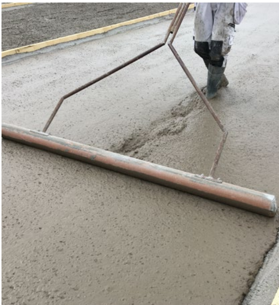
Figur 22 – Eksempler på jutning og SCC-beton [15]
