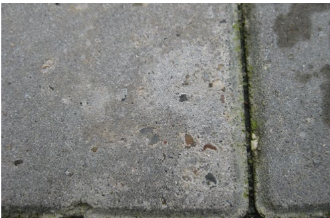
Figur 111 – Lyse plamager indikerer hvor kondensvandet har dryppet ned på overfladen.
