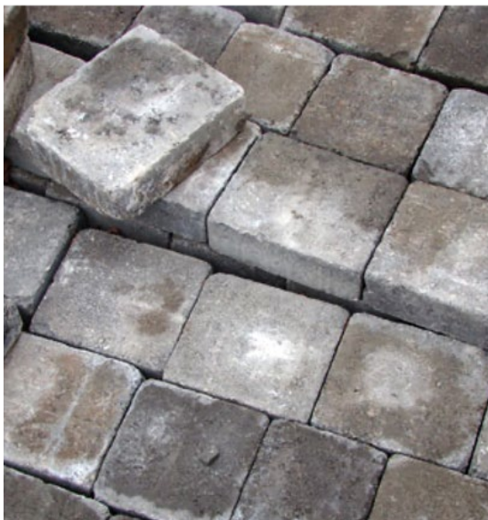
Figur 113 – Eksempler på kalkudfældninger
