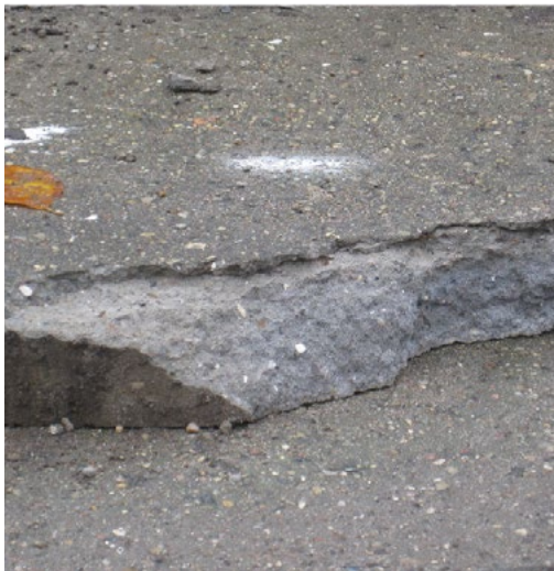
Figur 105 – Eksempel på delaminering i et-lags beton.
