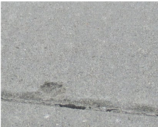
Figur 108 – Eksempel på napning i betonareoverflader.
