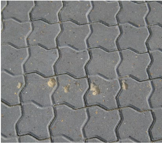
Figur 96 – Eksempel på siltklumper i fliser og belægningssten.
