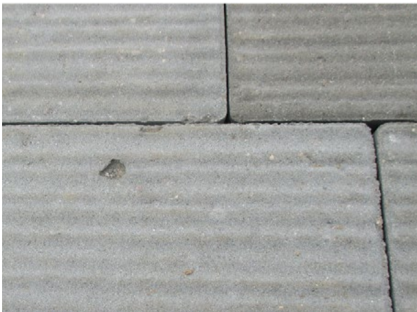
Figur 97 – Eksempel på frostklumper i fliser og belægningssten.
