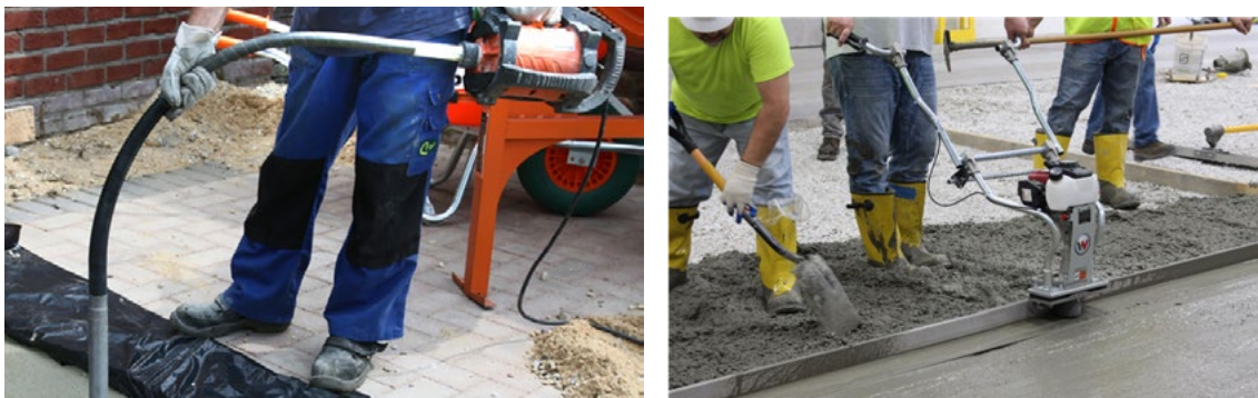
Figur 21 – Eksempel på vibrationsredskaber. Tv. Stavvibrator; Th. Bjælkevibrator
